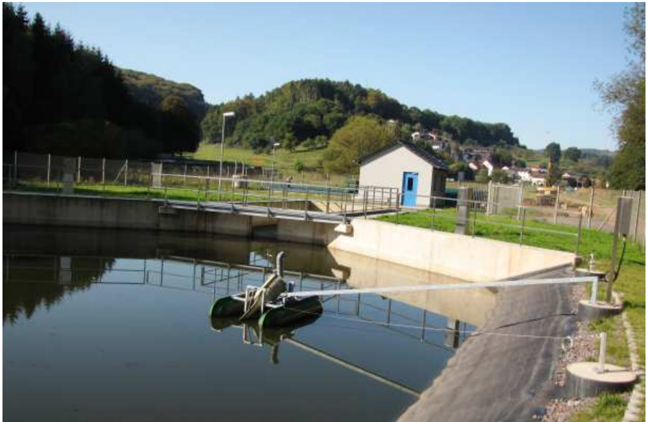
Gesamtansicht der Kläranlage Bethingen
