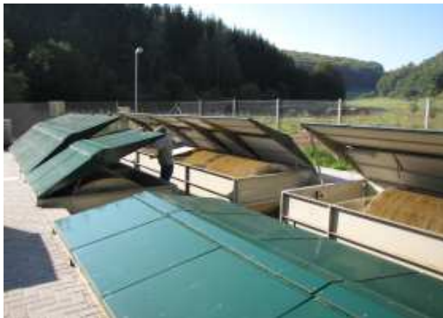
Scheibentauchkörperanlage
