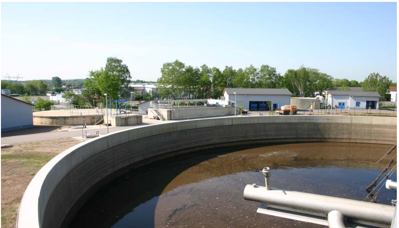
Teilansicht der Kläranlage Überherrn
