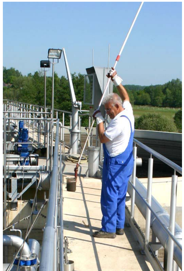
Probenahme im SBR-Becken
