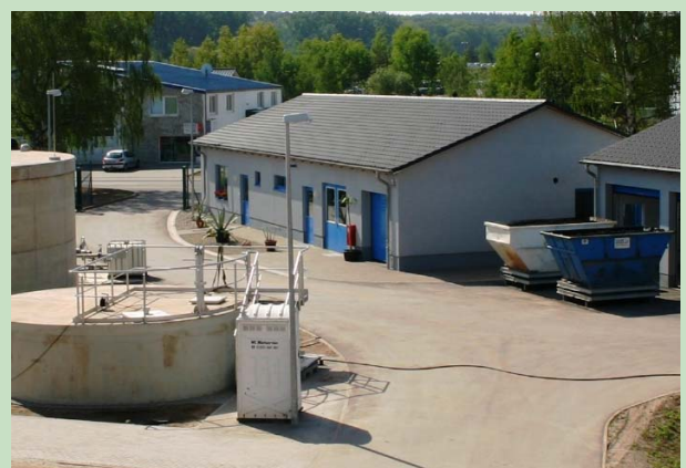
von li. nach re.: Schlamm Speicher, Eindicker, Betriebsgebäude und Schlamm entwässerung
