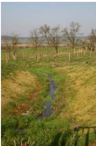
Auslaufgraben zum Bommersbach
