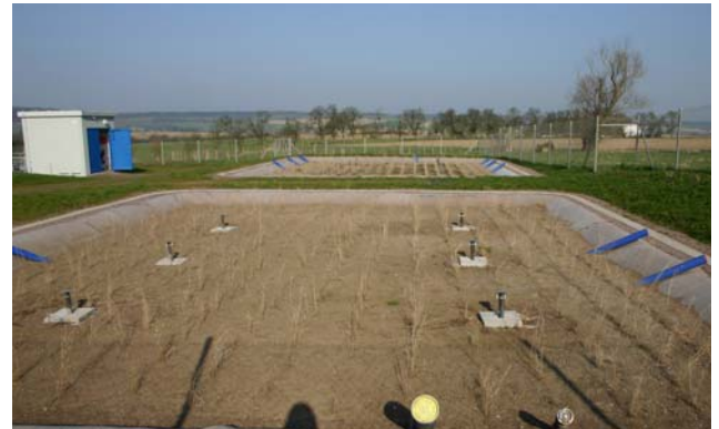
Pflanzenbeete der Kläranlage Utweiler
