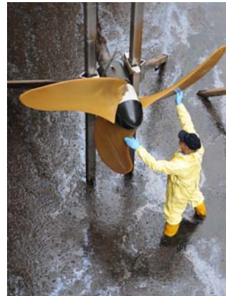
Blick in ein ungefülltes Belebungsbecken: Das linke Bild zeigt eines der großen Rührwerke, die das Abwasser durchmischen; auf dem rechten Bild sind die Belüfter zu sehen.
