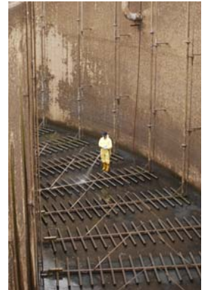
Blick in ein ungefülltes Belebungsbecken: Das linke Bild zeigt eines der großen Rührwerke, die das Abwasser durchmischen; auf dem rechten Bild sind die Belüfter zu sehen.
