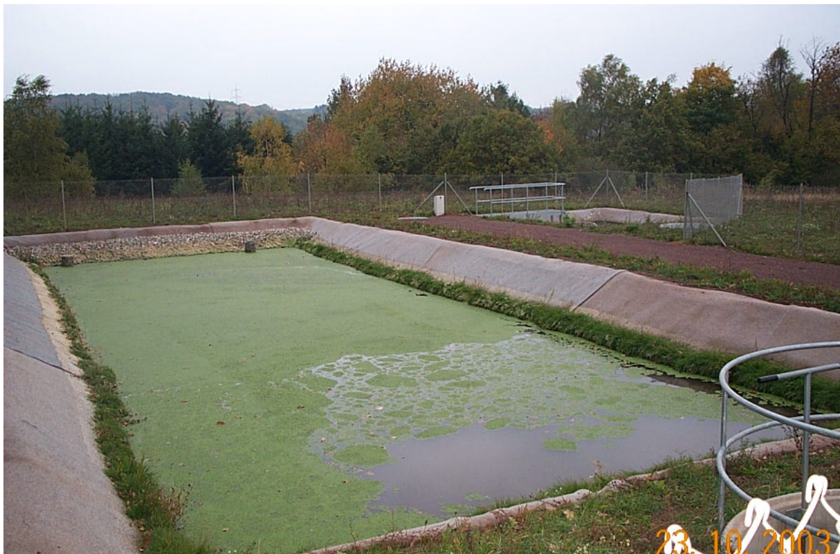
Abbildung 3: Absetzteich der Kläranlage Vogelsbüsch
