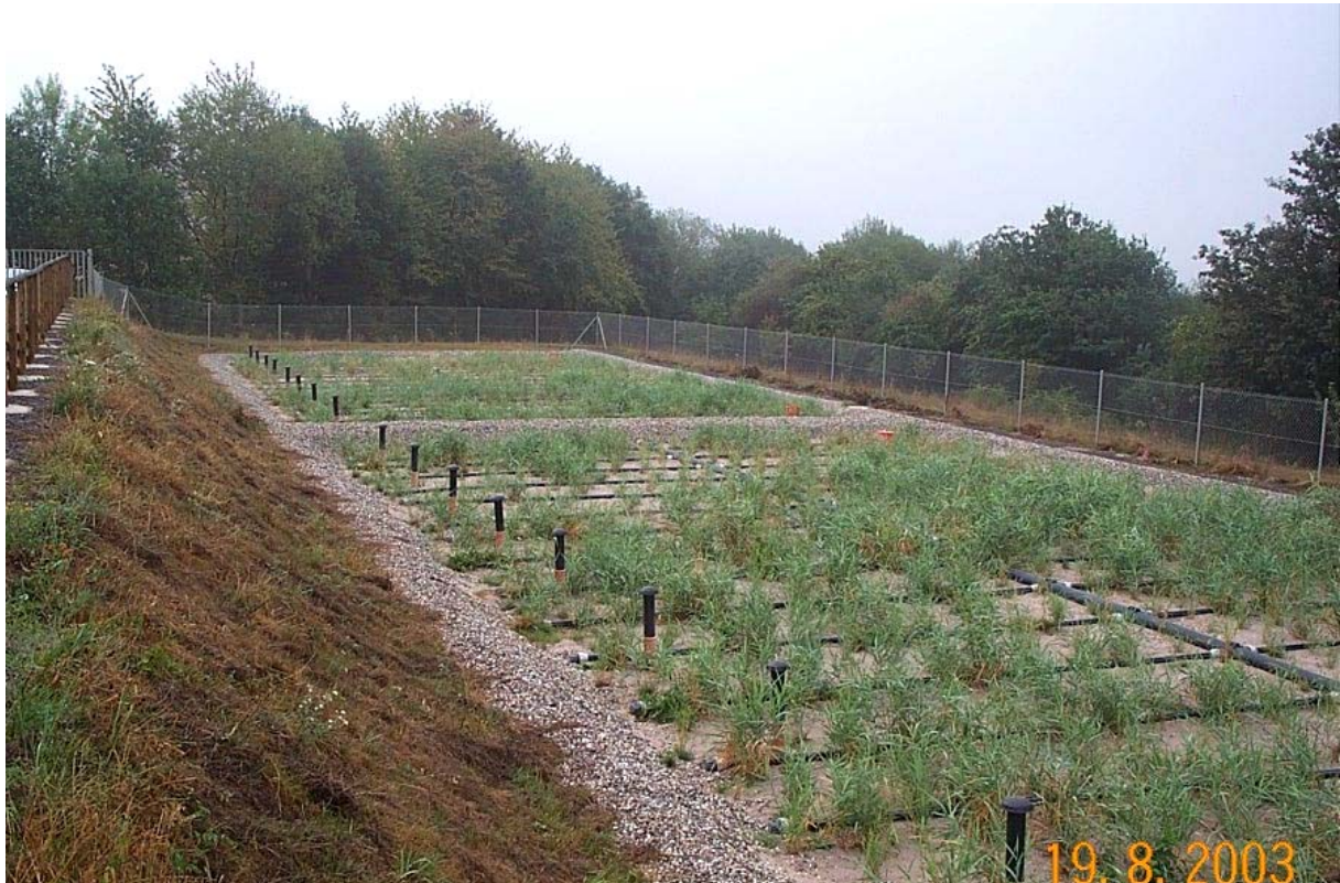
Abbildung 2: Pflanzenbeete der Kläranlage Reidelbach
