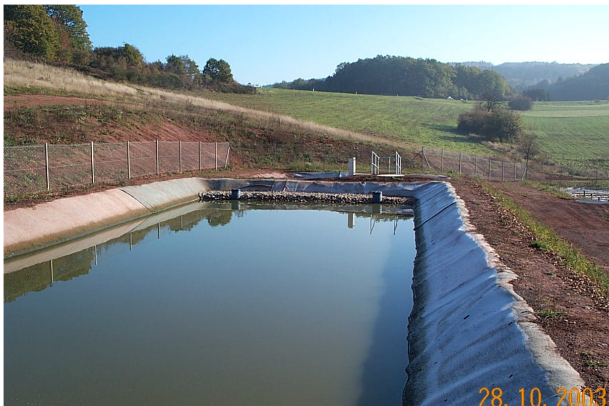
Abbildung 5: Absetzteich der Kläranlage Altland
