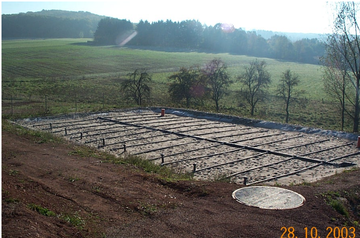
Abbildung 6: Pflanzenbeete der Kläranlage Altland
