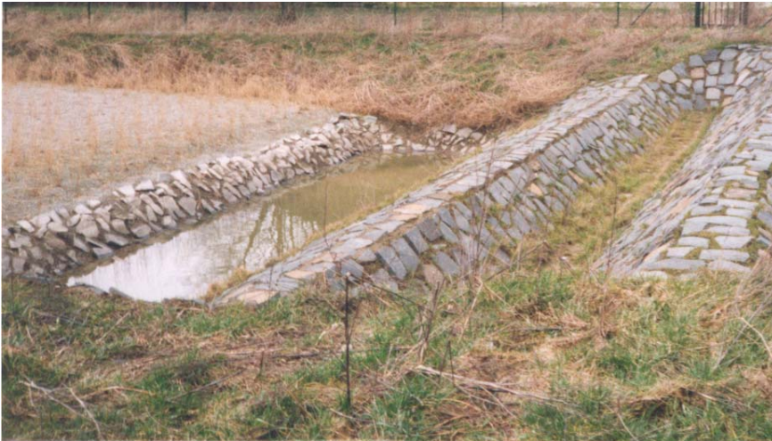
Bild 2: Zulaufgraben und Schlammfang von Beet 2
